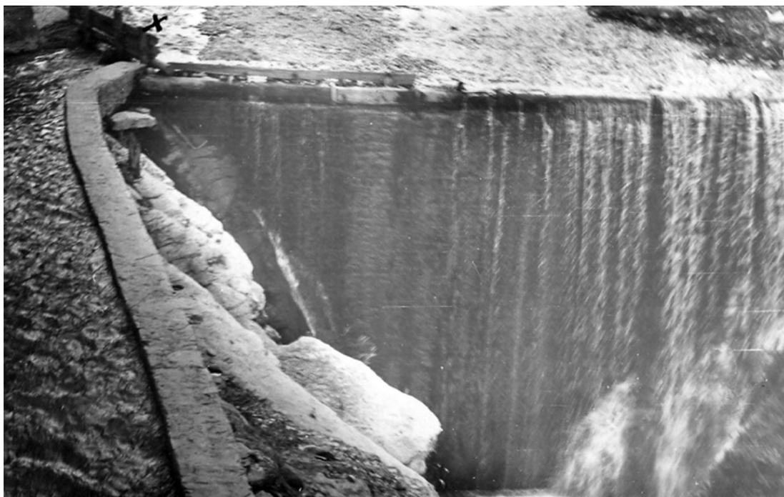
Рис. 6. Плотина для подъема воды в ирригационные каналы в Старом Чиркее. Построена на средства чиркеевского наиба, ген. Пазулава, вторая половина XIX в. Фото автора. 1965 г.
