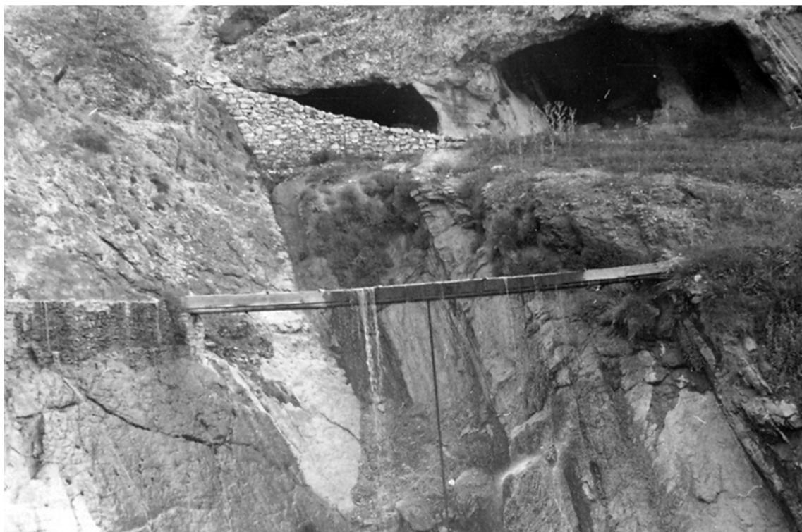
**Рис. 9.** Переброска воды через ущелье и тоннели-каналы, пробитые в скале, с. Гергебиль.
