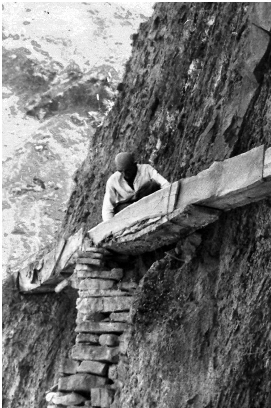
Рис. 11. Ремонт оросительного водовода в с. Корода.
