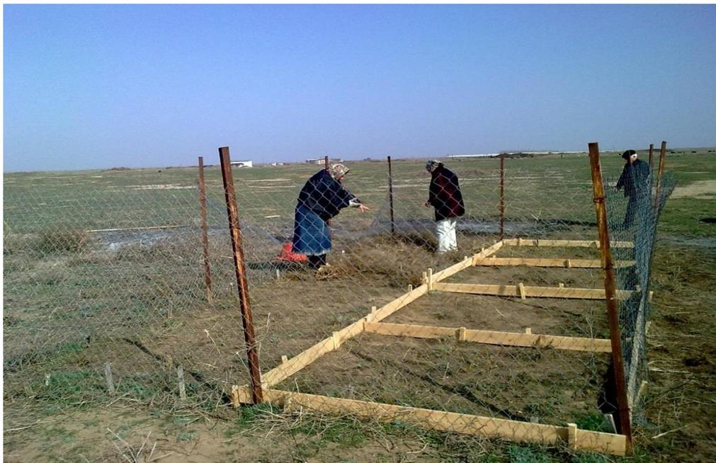
**Рис. 3.** Участок с искусственным препятствием для задержания илесто-песчаного потока
